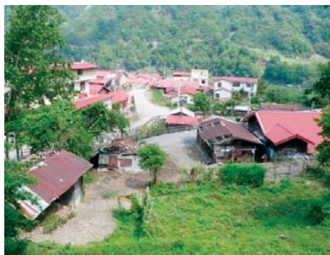
南投縣仁愛鄉親愛村-投縣 DF022 危險聚落
